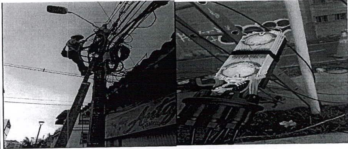
CONEXIÓN DE SERVICIOS
